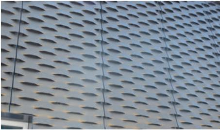
Elementgrößen von ca. 1200 × 3000 mm kamen zur Anwendung mit perfekten Maschenübergängen an den Stößen.
