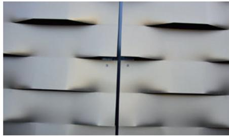
Vertikale Aneinanderfügung der Streckmetalltafeln mit darunterliegenden Hutprofilen.
